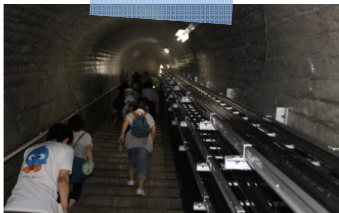
龍ヶ鼻ダム堤体内
