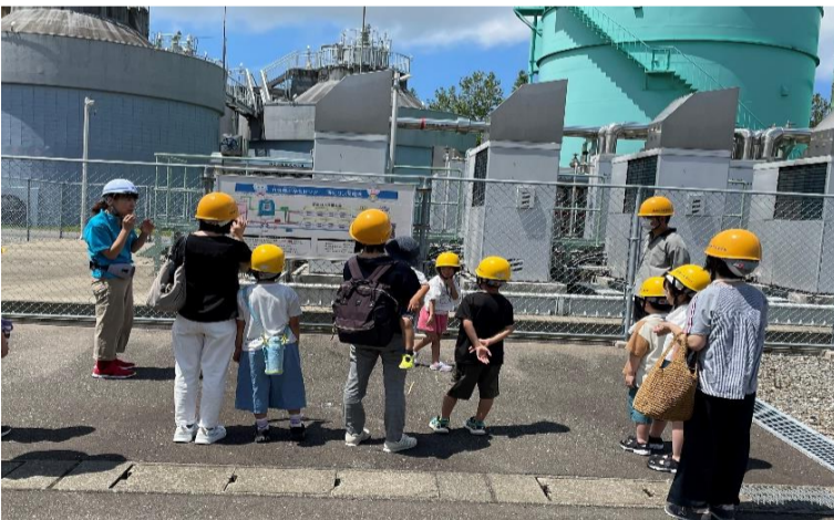
・消化ガス発電設備の見学
