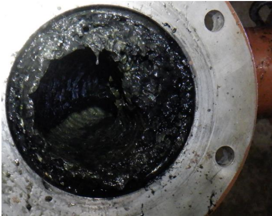
【写真1：汚泥閉塞状況】
